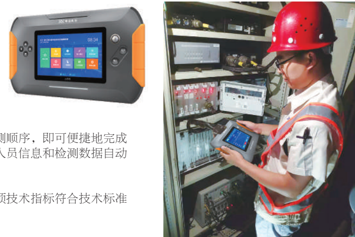
机车信号在车综合检测系统。
